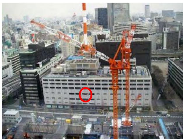
(a) 定常クレーン作業時
