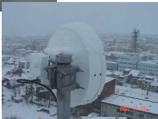
滝川市役所屋上
