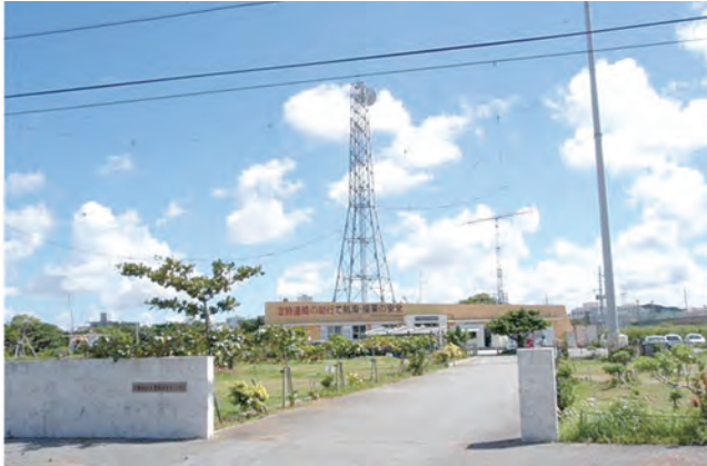
写真 3-1 沖縄県漁業無線通信センター外観
