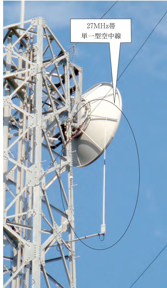
写真 3-3 空中線設置状況
