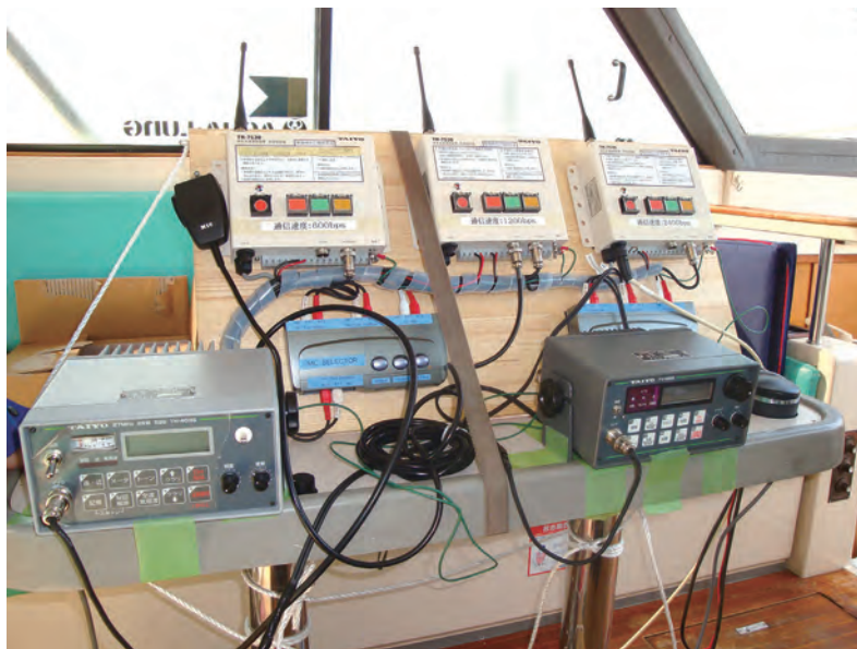
写真 3-5 無線機設置状況
