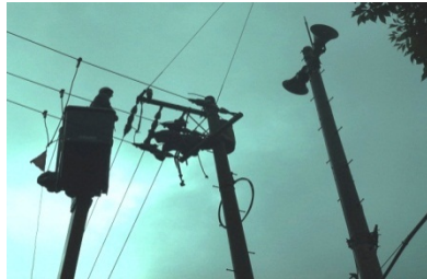
高圧線路の碍子取り替え工事
