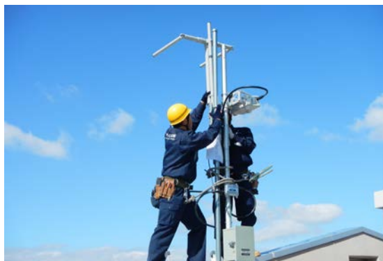
臨時災害放送局の送信アンテナを設置
