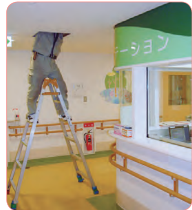
病院におけるICT機器の設置工事の例 (桃陽総合支援学校)
