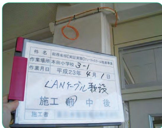
（参考）普通教室が増えた際に無線LANアクセスポイント用に LANケーブルを敷設した例（左は施工前、右は施工後） （本田小学校）
