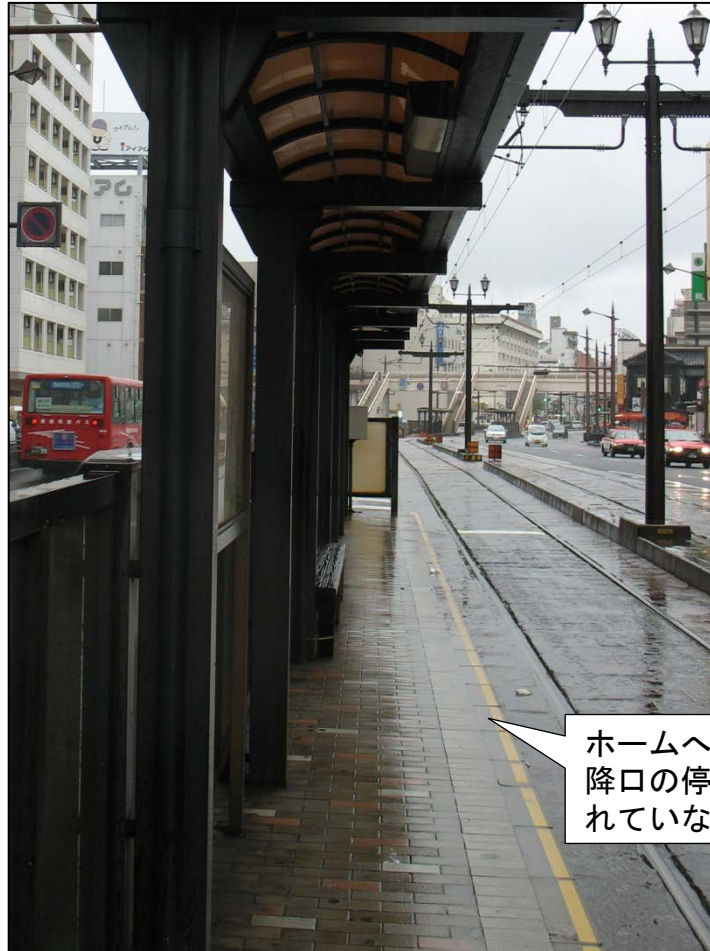
茂里町停留場（上りホーム）
