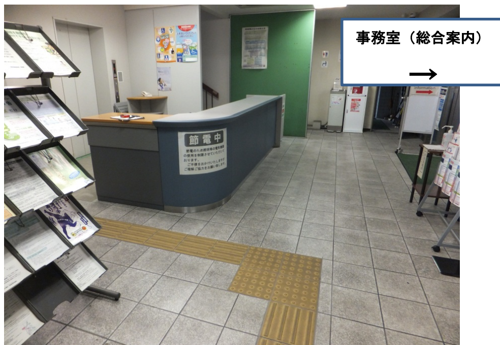
【玄関フロア内の点字ブロック】
