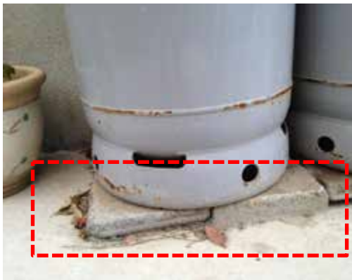
左右で高さの異なるコンクリートブロックを使用している。
