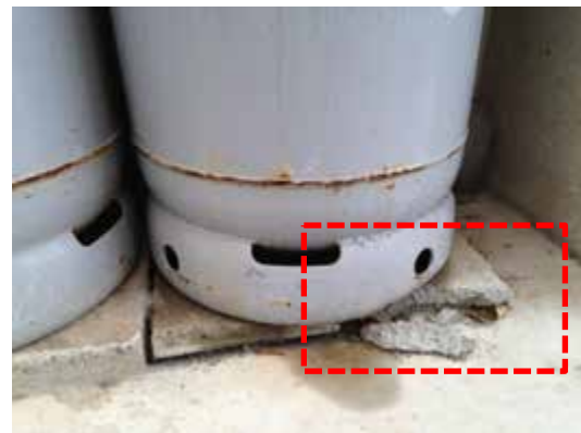
設置台の一部が破損している。
