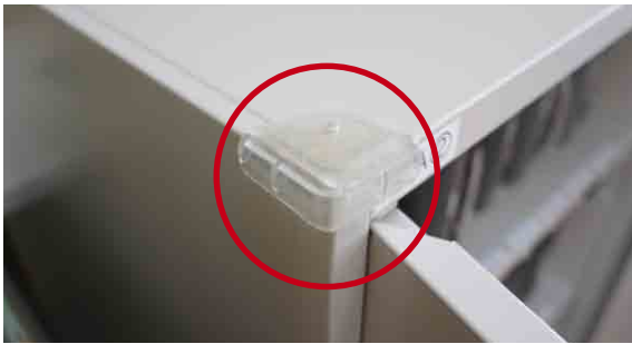
充電保管庫の突起部に緩衝材を貼り付けた例 (下地中学校)
