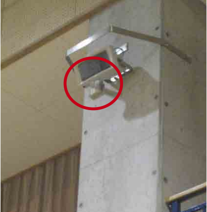
体育館に設置した無線LAN アクセスポイント (三雲中学校)
