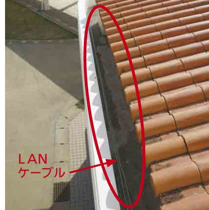
普通校舎棟と特別校舎棟を結ぶため 渡り廊下に敷設したLANケーブル (下地中学校)
