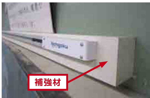
黒板の上下に補強材を設置し、強度の確保等の工夫をした上で、黒板取付式ボード型を設置した例 (横浜国立大学教育人間科学部附属横浜中学校)
