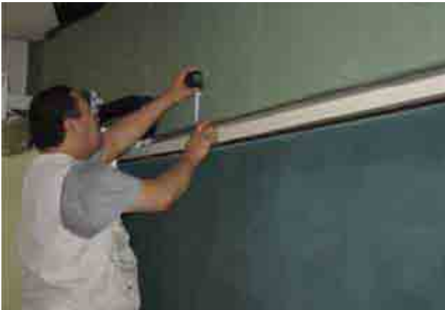
上レールの水平を調整している様子 (横浜国立大学教育人間科学部附属横浜中学校)
