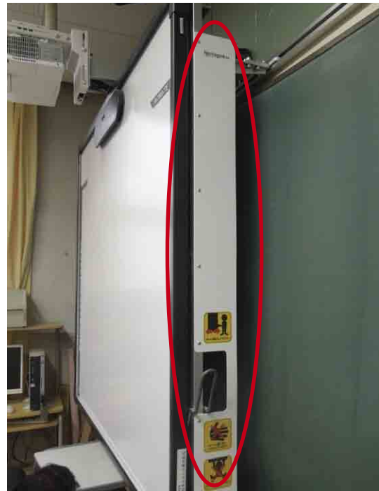
電子黒板の側面に 挟まれ防止のガード板を取り付けた例 (横浜国立大学教育人間科学部附属横浜中学校)
