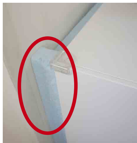
充電保管庫が押されてコンセントを潰さないように、ストッパーを挟んだ例 (上越教育大学附属中学校)
