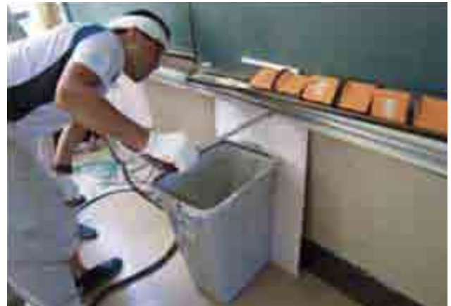
下レールの ゆが みを補正している様子 (横浜国立大学教育人間科学部附属横浜中学校)
