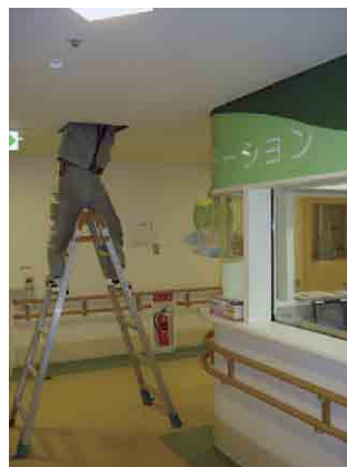
病院におけるICT機器の設置工事の例
