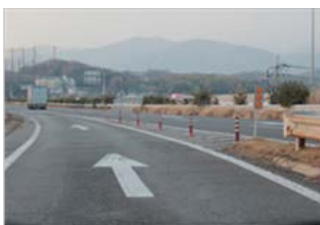
〈本線合流部〉大型矢印路面標示、ラバーポール設置
