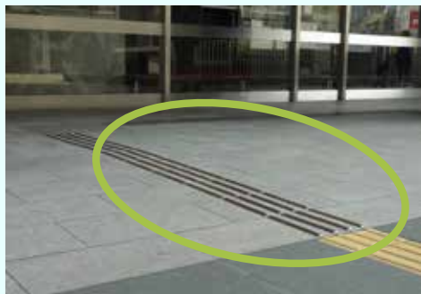
【福岡合同庁舎本館】
