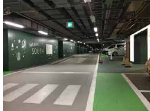
【駐車場(改修後)】
