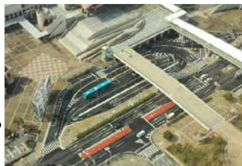
中央バスロータリー(改修後)
