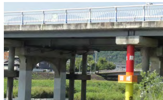
橋脚に注意、警戒、危険とペイントし、危険水位が一目で分かるよう工夫（多治見市内土岐川）
