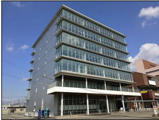
南海和歌山市駅ビル
