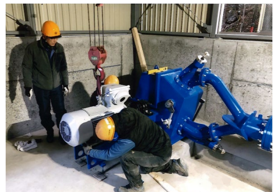
【発電機の設置】
