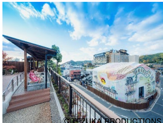
【工事用仮設物の道後温泉本館ラッピングアートでまちの回遊性を高める】 22
