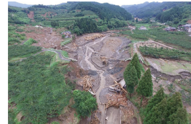
平成29年7月九州北部豪雨による 河川と農地の被害状況
