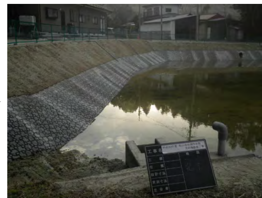
ため池堤体整備：施工後
