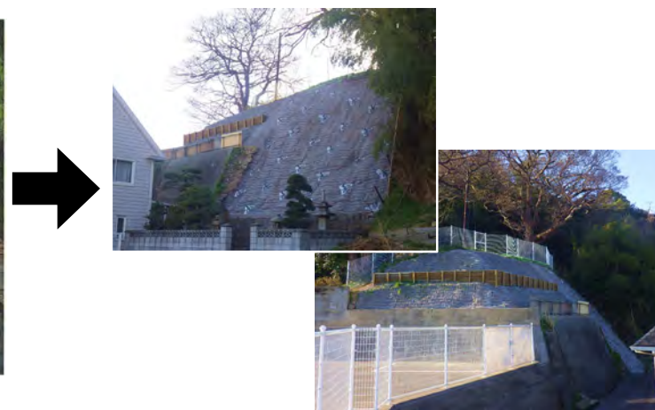
急傾斜地法面对策：施工後
