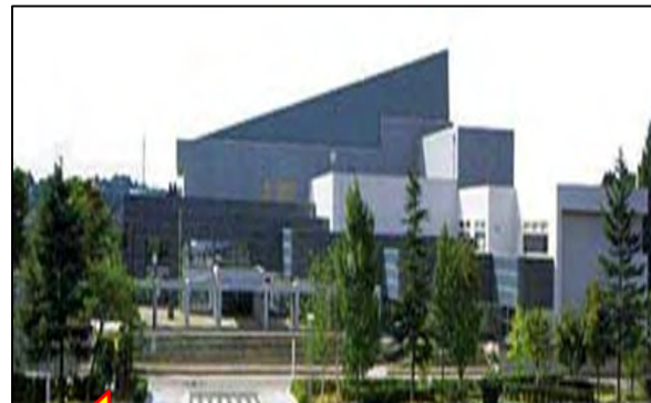
須賀川市文化センター【改修前】
