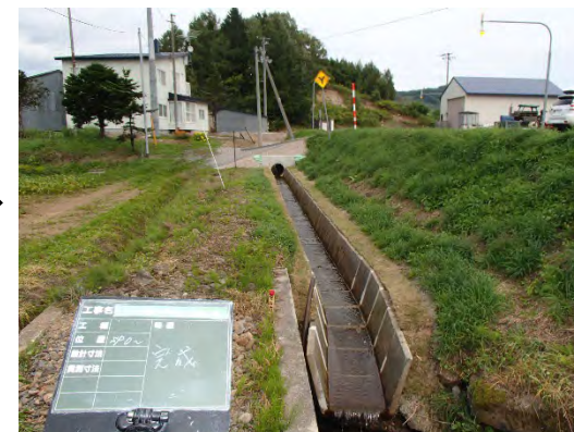
水路整備：施工後
