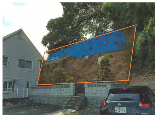
急傾斜地法面对策：施工前
