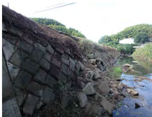
護岸整備：施工前
