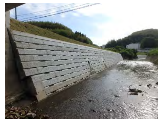
護岸整備：施工後
