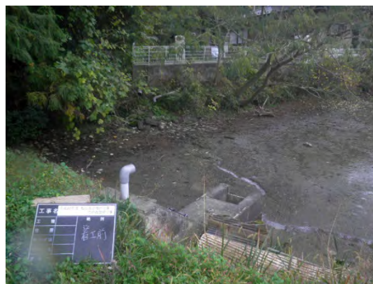
ため池堤体整備：施工前
