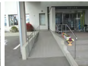
出入口の段差解消 事業費：30万円程度
