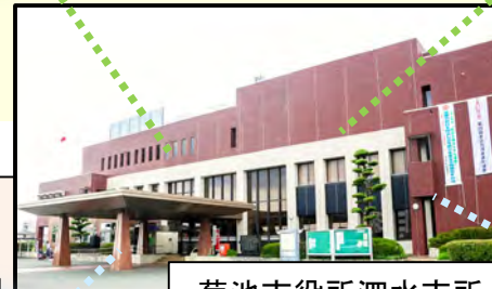
菊池市役所泗水支所
