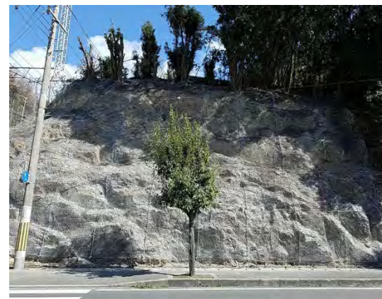
法面防護：施工後
