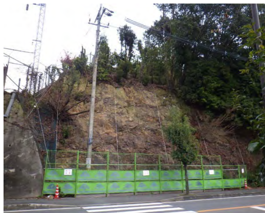
法面防護：施工前
