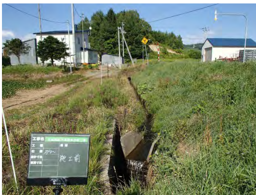
水路整備：施工前
