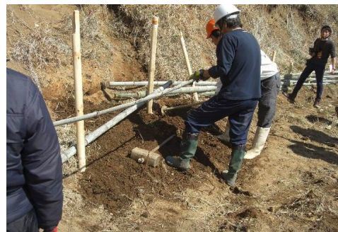
棚田復旧作業
