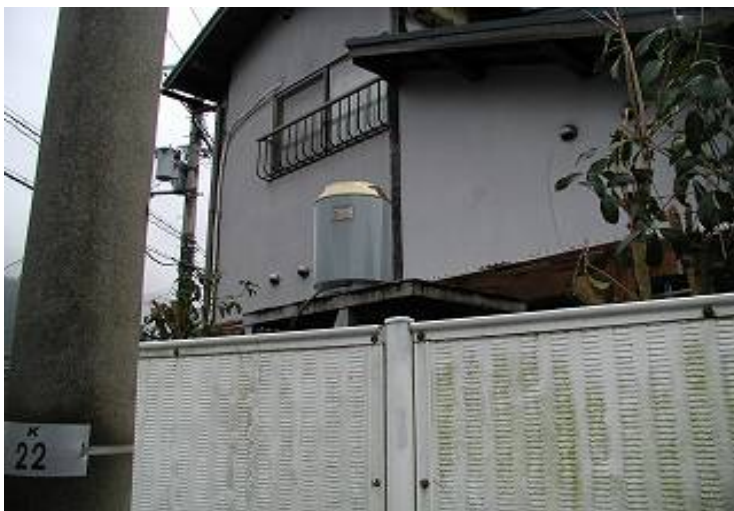
雨量計と建物、樹木、電柱が近接し、風向風速によって雨量観測に影響
