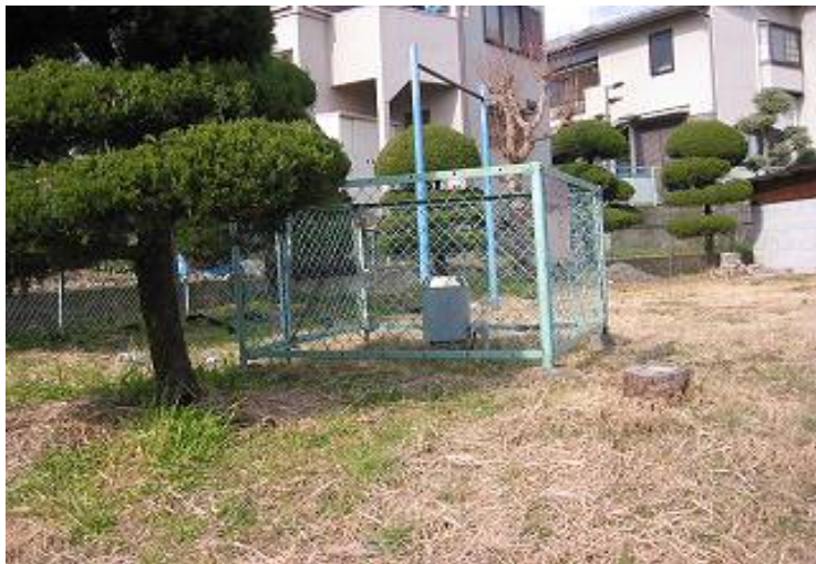
雨量計とフェンス、樹木が近接し、風向風速によって雨量観測に影響
