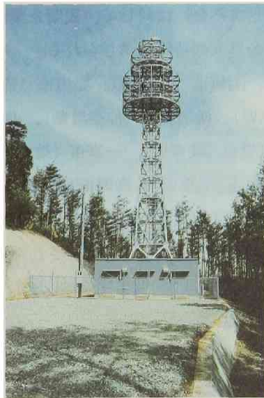
移動通信用鉄塔
