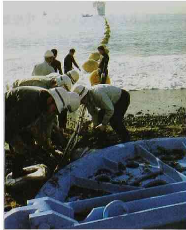
海底ケーブルの敷設
