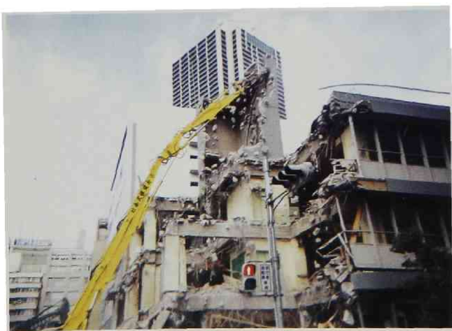
解体される神戸港郵便局
