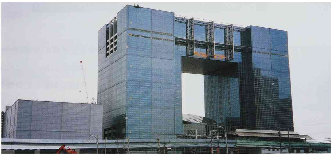
東京テレポートセンター(テレポート、特定電気通信基盤施設及びインテリジェントビル)
