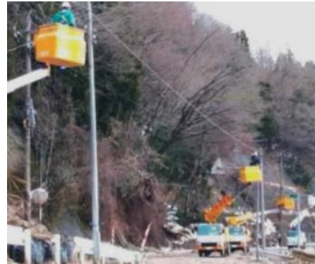
図表 I-1-2-5 通信インフラ（携帯電話）の被害（光ファイバの被害・張替）
