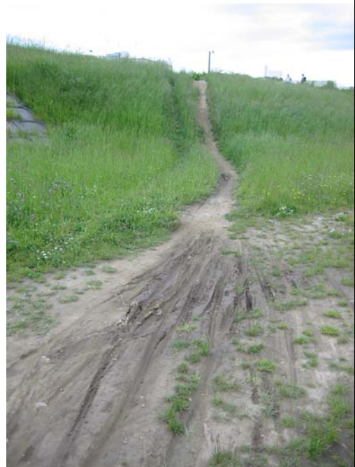
(苗穂3丁目付近) 下から見た損傷
