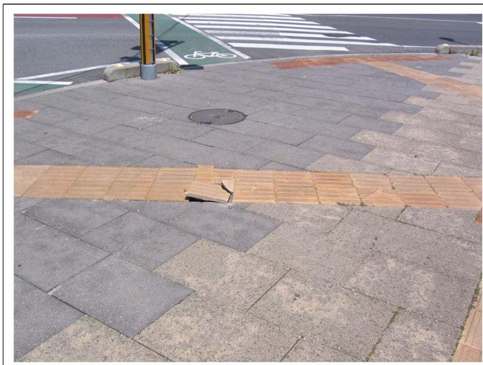
点字ブロックが破損してめくれ上がっている。
