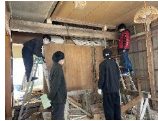
▲空き家改修作業の様子
