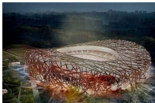
北京五輪メインスタジアムの 照明制御
