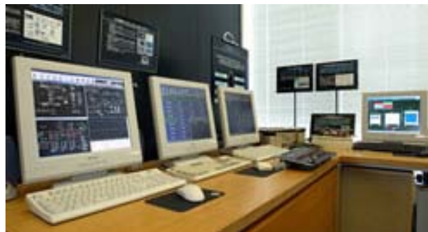
ビル管理システム (清水建設ITソリューションラボ)
