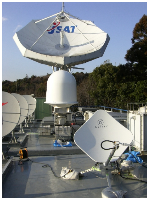
図 5.2 衛星伝送で使用した送受信地球局（手前：送信局、奥：受信局）
