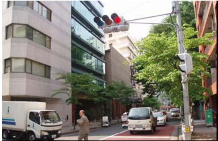
港区役所 道路の東側（7階、4階、6階）
