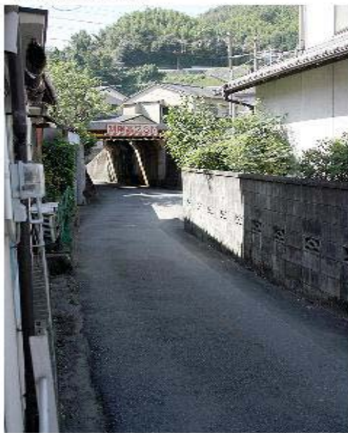
2.3メートルの高さ制限があり、消防車などが通れない別府市浜脇地区の狭い道路
