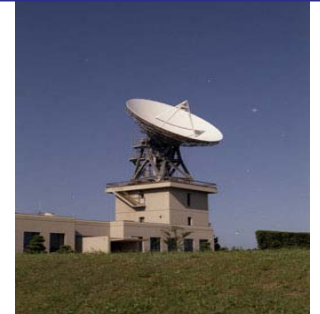
CS実験用13メートルパラボラアンテナ(鹿島)
