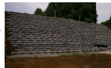
テール土嚢を用いたため池の高耐久性化
