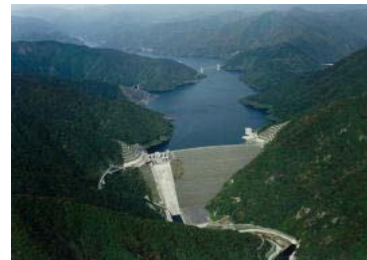
ダムからの放流(徳山ダム)
