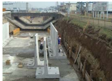
水路の改築(利根導水)
