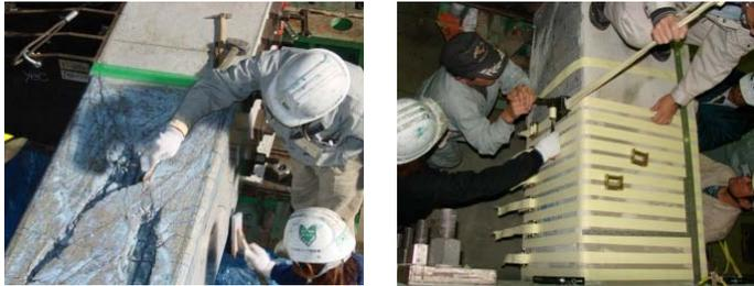
機械式定着繊維バンド巻き立て工法による応急復旧
