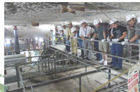
耐震改修工事の現場見学
