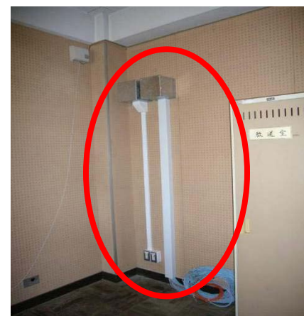
既設サーバ室がないため、放送室内の空きスペースに電源、LAN配線を用意
