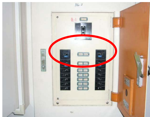
分電盤の増設工事
