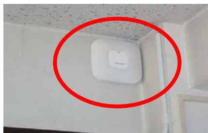
各普通教室に2個の無線LANアクセスポイントを天井付近に対角線上に設置。
