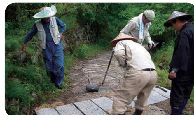
中山道整備作業 住民の参加により歩道を整備し、快適な中山道を維持しています。多くのハイカーがウォーキングを楽しんでいます。
