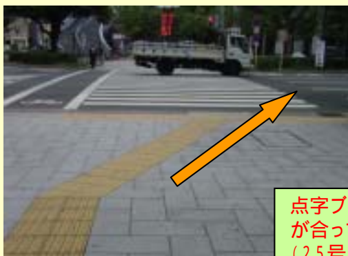
点字ブロックが途切れている (25号 大阪市東住吉区内)
