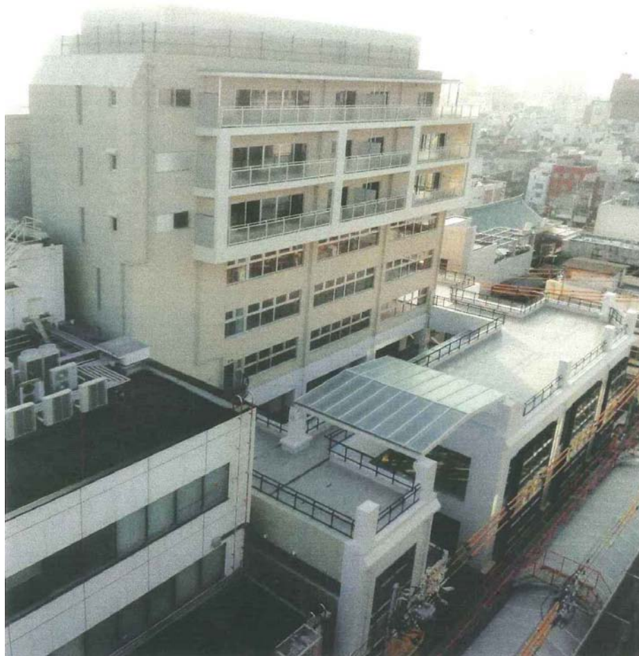
現在整備中のメディカルモール 外観
