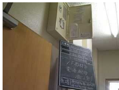
充電保管庫の電源を確保するために新たに分電盤を設置した例
