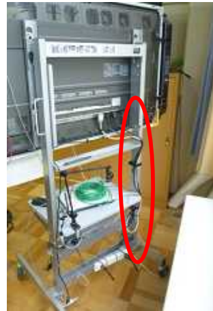
児童の安全を考慮して機器の配線を整理した例
