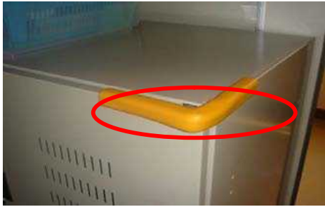
充電保管庫の突起部に緩衝材を貼り付けた例
