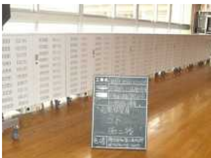
充電保管庫を各階のオープンスペースに集約して設置した例
