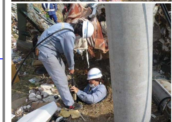
瓦礫の中での電柱の建設作業
