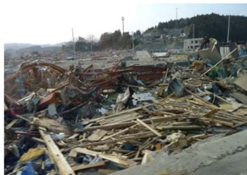
町の中心部は甚大な被害
