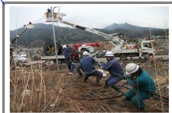
架空ケーブルを複数の作業員で敷設
