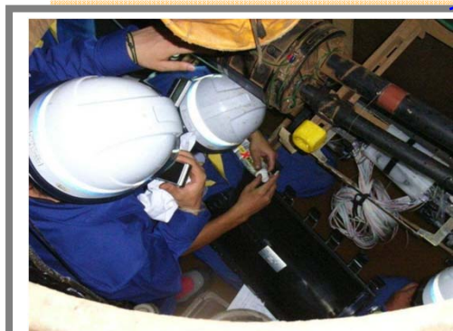
余震が続く中、マンホール内のケーブル接続作業
