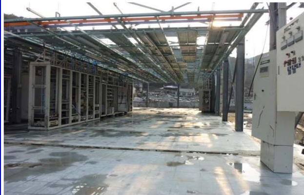
建物内の瓦礫等を撤去し、清掃
