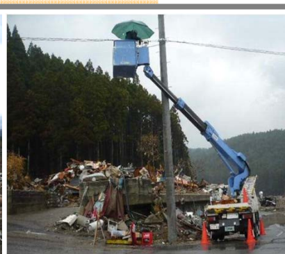
雨天時のケーブルの接続作業
