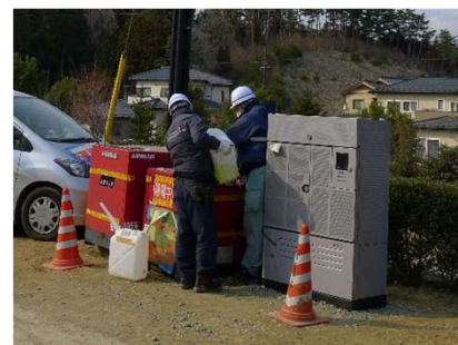
停電中の避難所では、電源確保のため、張り付きが必要
