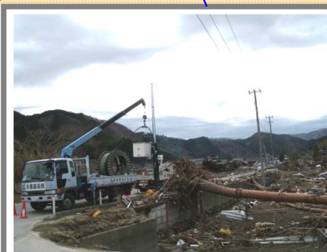
瓦礫の中のケーブル敷設作業
