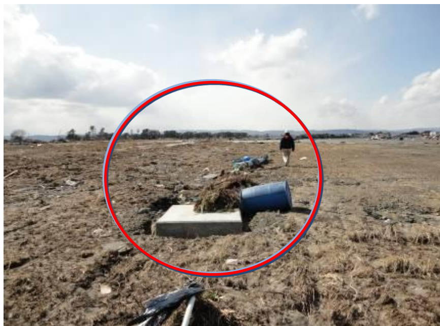
津波で倒壊した基地局(名取市)
