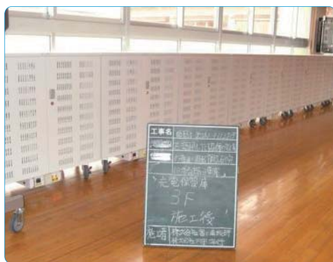
充電保管庫を各階のオープンスペースに集約して設置した例
