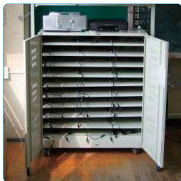
タブレットPCを4台または8台ずつ充電する充電保管庫の例
