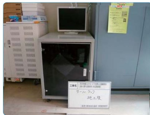
児童がサーバーに触れないように職員室に設置している例
