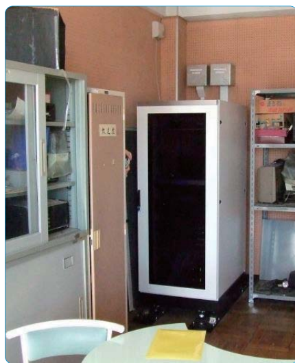
児童がサーバーに触れないようにラックに収納している例(放送室)
