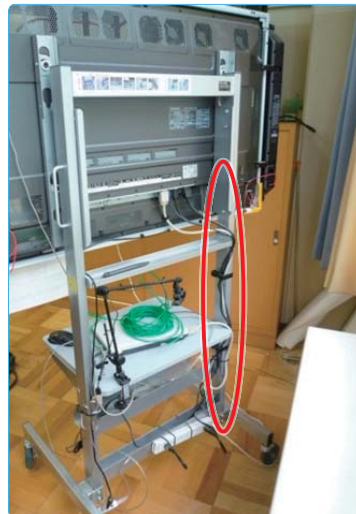
児童の安全を考慮して機器の配線を整理した例
