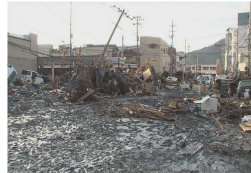
釜石市市街地の被災状況
