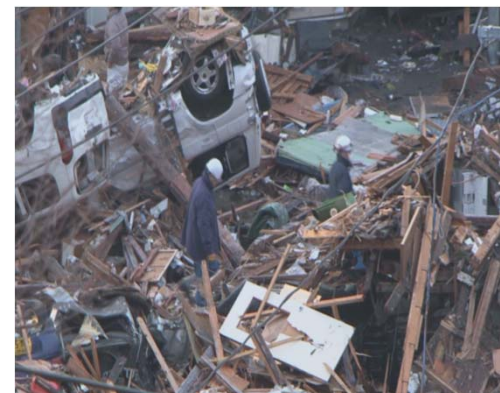
釜石市商店街の被災状況
