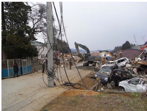
津波の被害を受け た気仙沼ケーブ ルネットワーク(株)の幹 線光ケーブル
