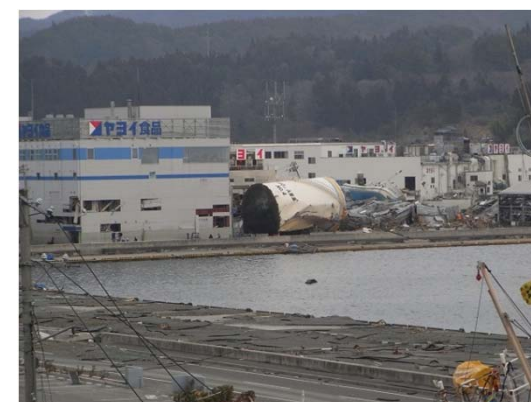
火災の原因と なった石油タンク
