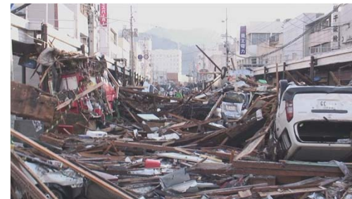
釜石市商店街の被災状況
