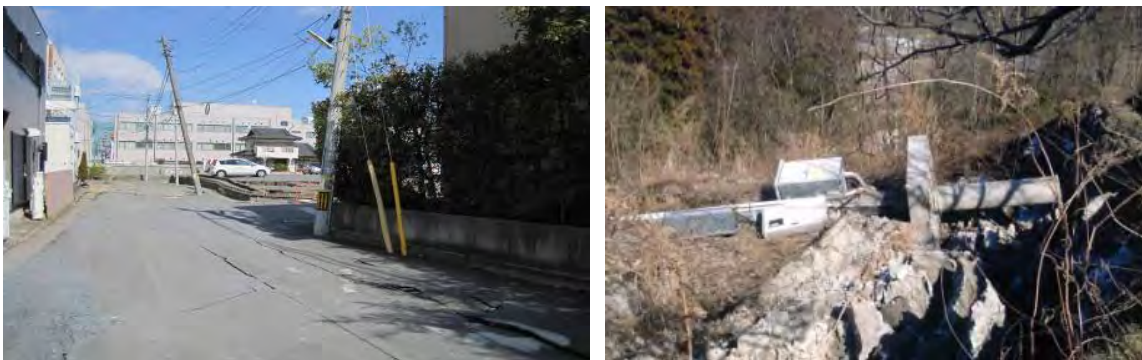
図 1-4 液状化により傾斜した電柱と土砂崩れにより倒壊した携帯電話基地局
