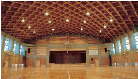
体育館棟の天井部は桧の集成材で、中央部4段・端部6段に編んだ木材で支えるラメラ・ルーフという構法で、木の強さ美しさを全面に出した構造になっている。
