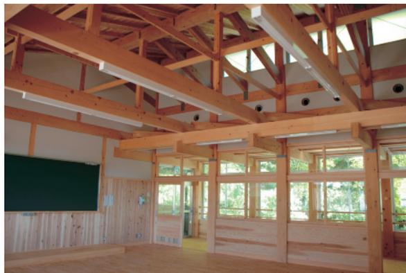
普通教室棟の2階の木造部分は、教室の桁行きの両側の柱を貫通した肘木で受け支点間を短くすることで梁断面を小さくし、接合部の剛性力やねばりを持たせた構造になっている。
