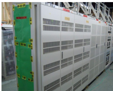
【STEP2】外壁等をビニールシート・ベニヤ板で応急復旧し、建物内に新たに電力設備・通信設備を設置
