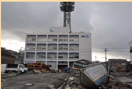
津波により浸水した門脇ビル
