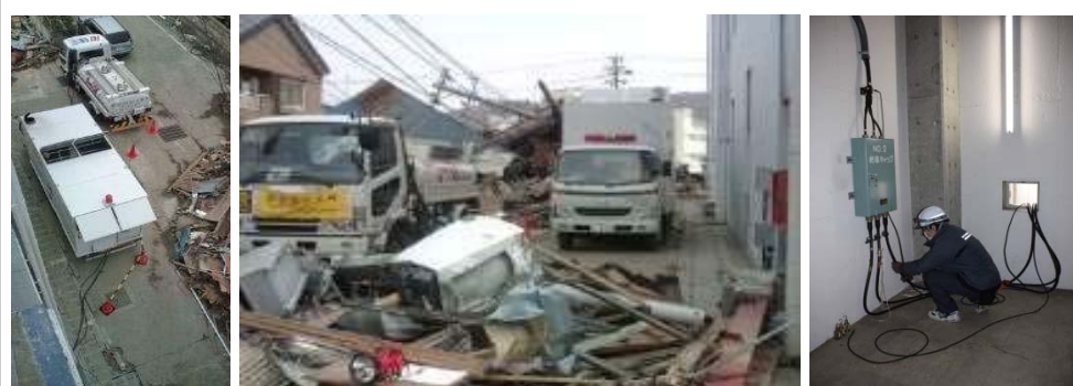
【STEP3】移動電源車を配備し接続
