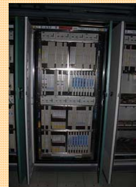
浸水を免れた上位階の機械室
