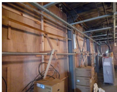
【STEP2】外壁等をビニールシート・ベニヤ板で応急復旧し、建物内に新たに電力設備・通信設備を設置
