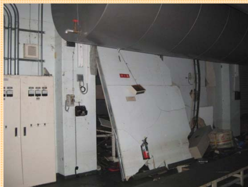
電力設備(1F)が大きく損傷
