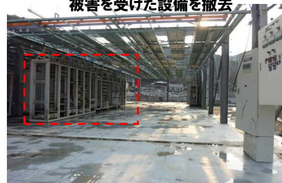
【STEP1】建物内外の泥・瓦礫等の掻き出し、被害を受けた設備を撤去
