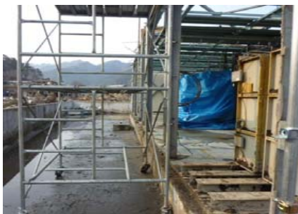
【STEP2】外壁等をビニールシート・ベニヤ板で応急復旧し、建物内に新たに電力設備・通信設備を設置
