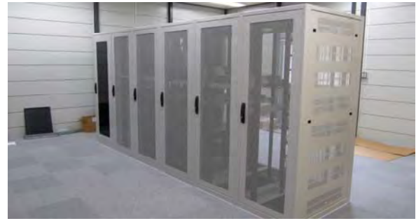
(左：仮庁舎サーバ室の無停電電源装置、右：同室内サーバラック、名古屋市提供写真)
