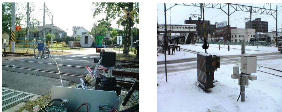
図 1.1-9 鉄道踏切障害物検知システム
